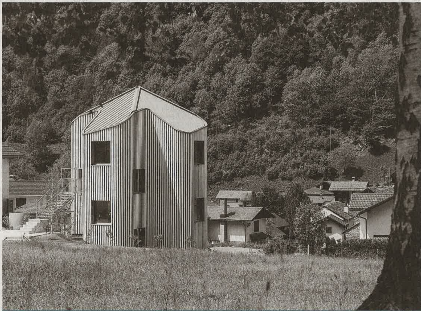
Das Gebäude ist aus dem Material, das im Tal wächst und das der Architekt liebt – Holz
